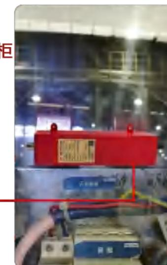
通讯机房由于机器设备集中、线路种类繁多、布线密集，工作连续性高，属于重点防范电气火灾场所，对抑制、扑灭火灾要求很高，因此对火灾预防必须做到早发现、早干预，争取在火灾造成大面积设备毁坏前进行灭火，电气火灾自动灭火系统可确保被保护设备的同时，在火灾及早期进行灭火。
